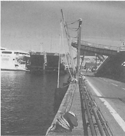
岸壁に設置された網ぶら下げ用の支柱
